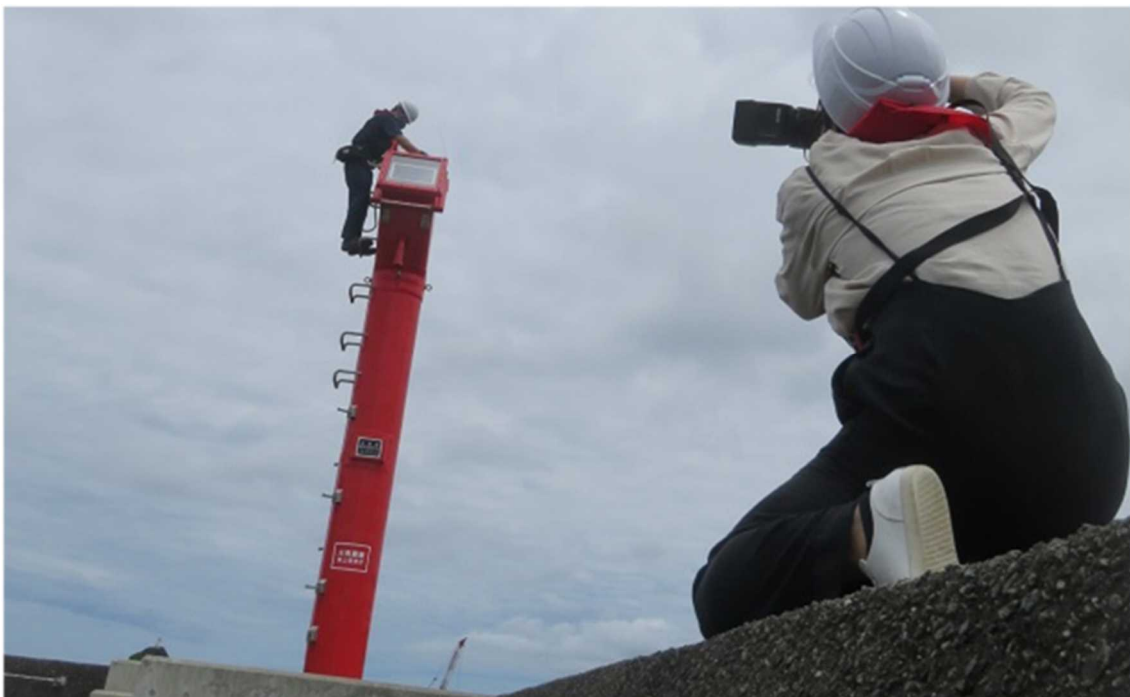
名瀬港西防波堤灯台の点検と南海日日新聞の取材
